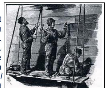
Kalfatern und Pichen eines Holzschiffes, von links mit Dweil, Kalfateisenhammer, Schaber
